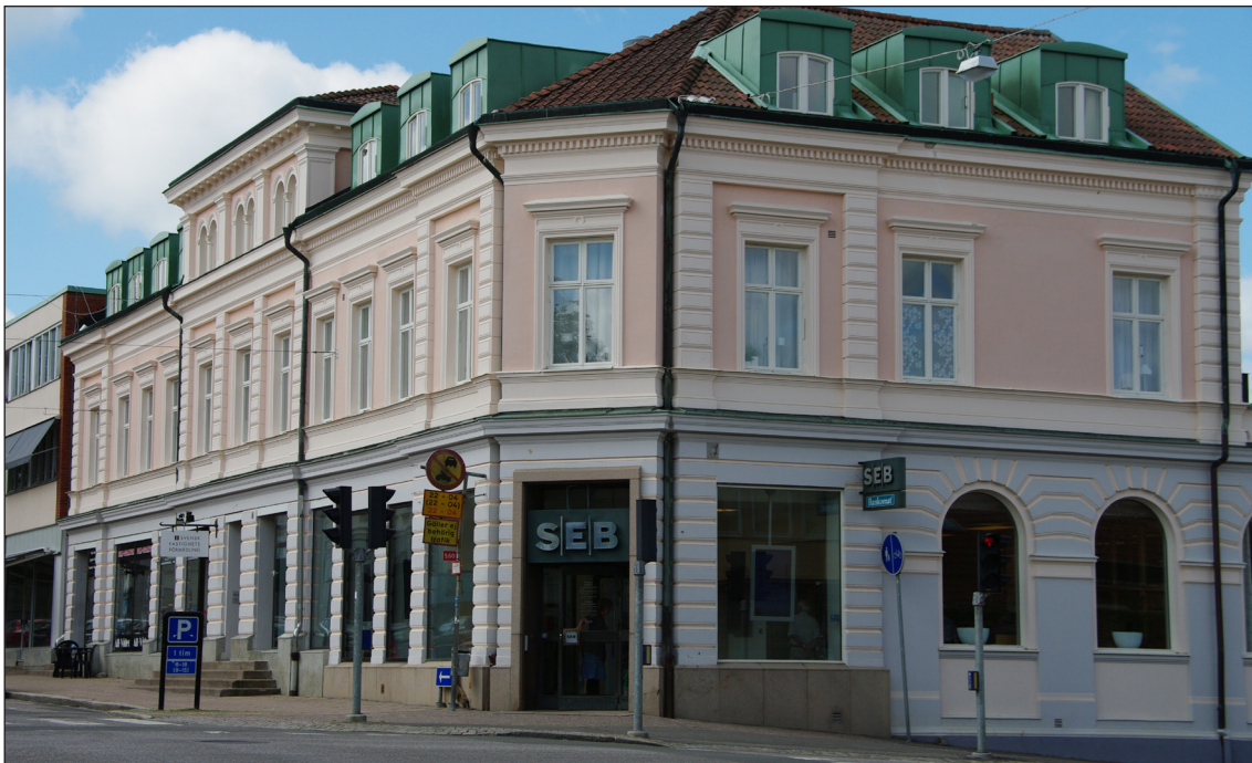
Vy från S:t Olofsgatan, över fastighetens äldre bebyggelse i den norra delen.
